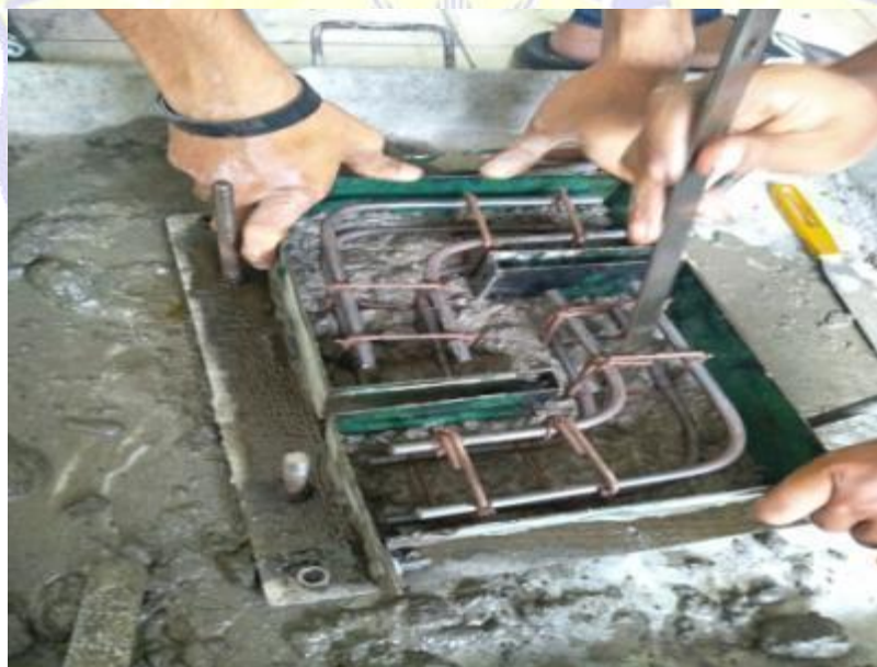
PENGISIAN BETON SEGAR PADA CETAKAN
