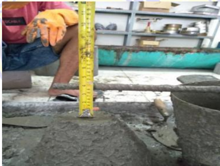
PEMERIKSAAN NILAI SLUMP BETON SEGAR
