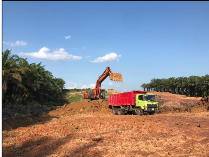
Gambar 2.5. Pengupasan Tanah Pucuk ( Top Soil )
