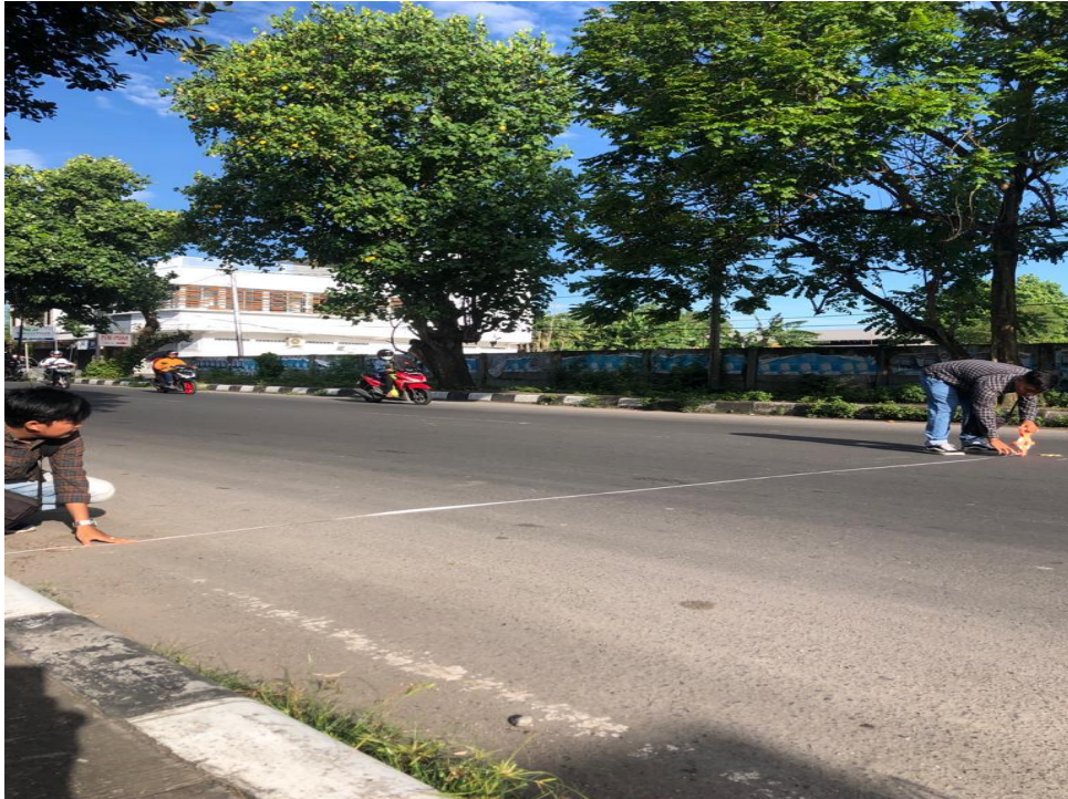
Gambar L.1 : Pengukuran Lebar Jalan
