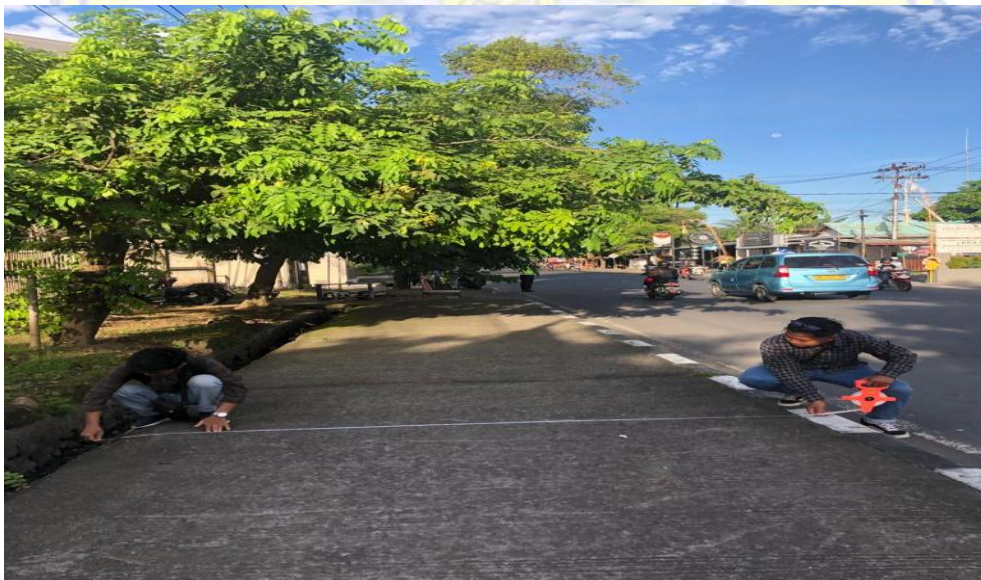
Gambar L.2 : Pengukuran Bahu Jalan
