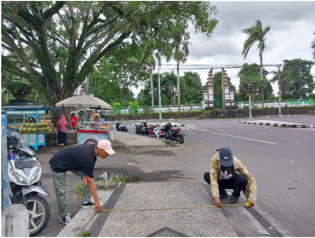
Pengukuran Bahu Jalan/Trotoar Jl.suranadi Lengan Utara
