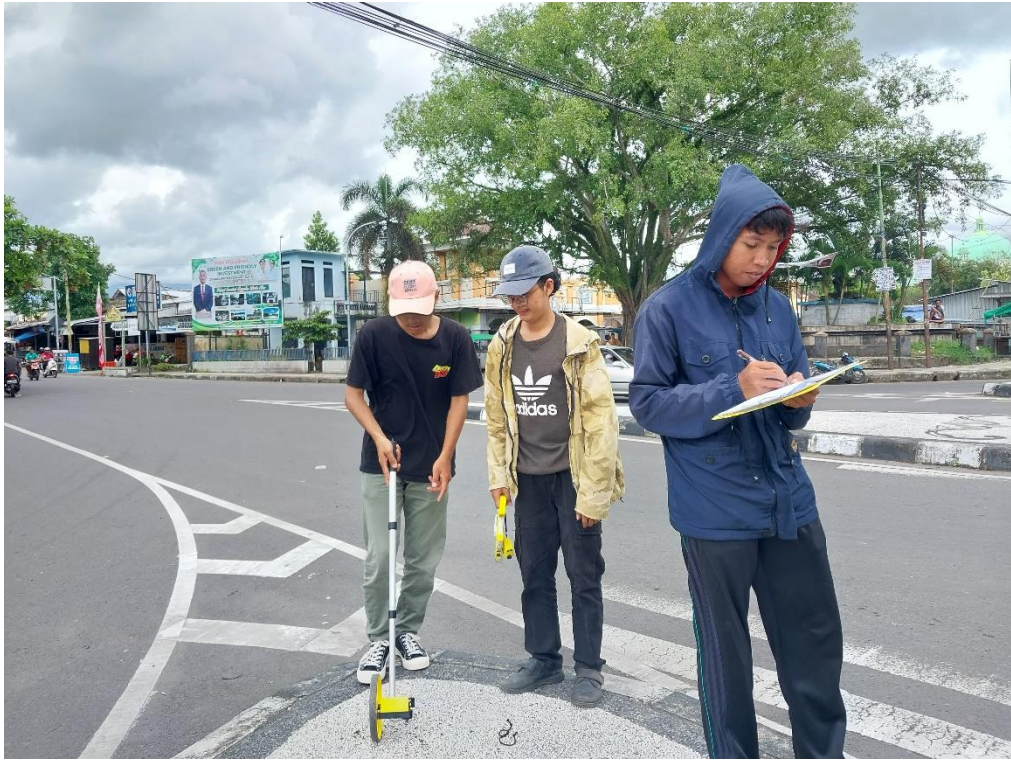
Pengukuran Median Jalan
