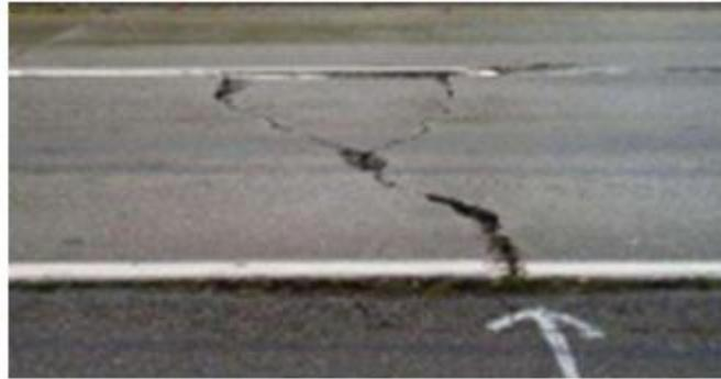
Gambar 2.6 Retak Sambungan Bahu Perkerasan
