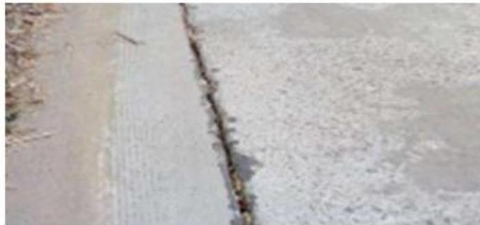
Gambar 2.8 Retak Sambungan Pelebaran Jalan
