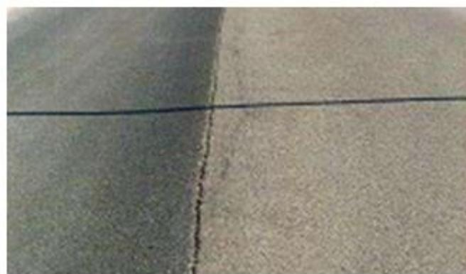
Gambar 2.7 Retak Sambungan Jalan
