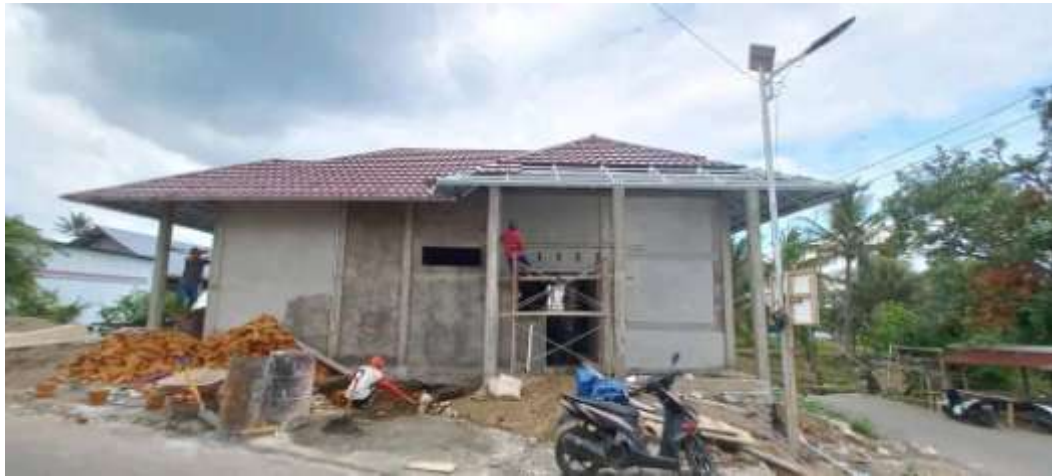
Pelaksanaan pembangunan kantor Desa Baturakit
