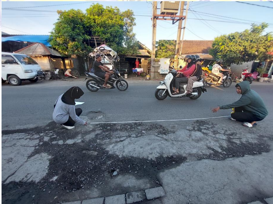
Gambar pengambilan data kerusakan
