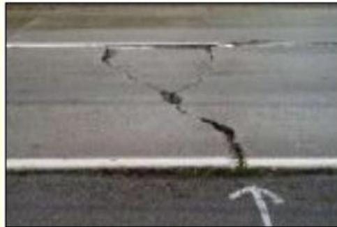
Gambar 2.7 Retak Sambungan Bahu dan Perkerasan.
