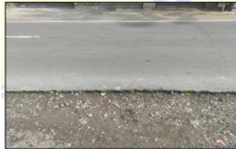
Gambar 2.17 Penurunan pada Bahu Jalan.
