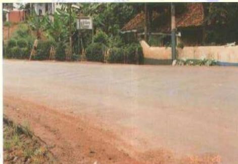
Gambar 2.10 Retak Bergelombang/Keriting.
