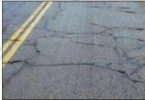
Gambar 2.8 Retak Kotak (*Block Crackng*).
