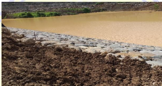
Gambar 2.7 Timbunan Rip-Rap (Zona 6) (Sumber : data proyek, 2022)
