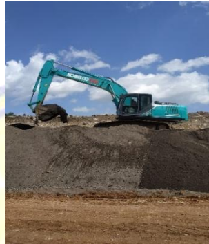
Gambar 3.24 Excavator (Sumber : Dokumentasi, 2023)
