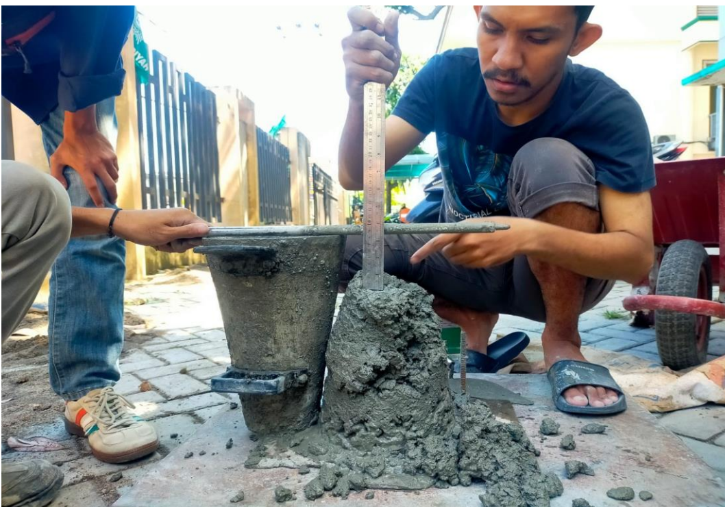
Proses Pemeriksaan Slump Test
