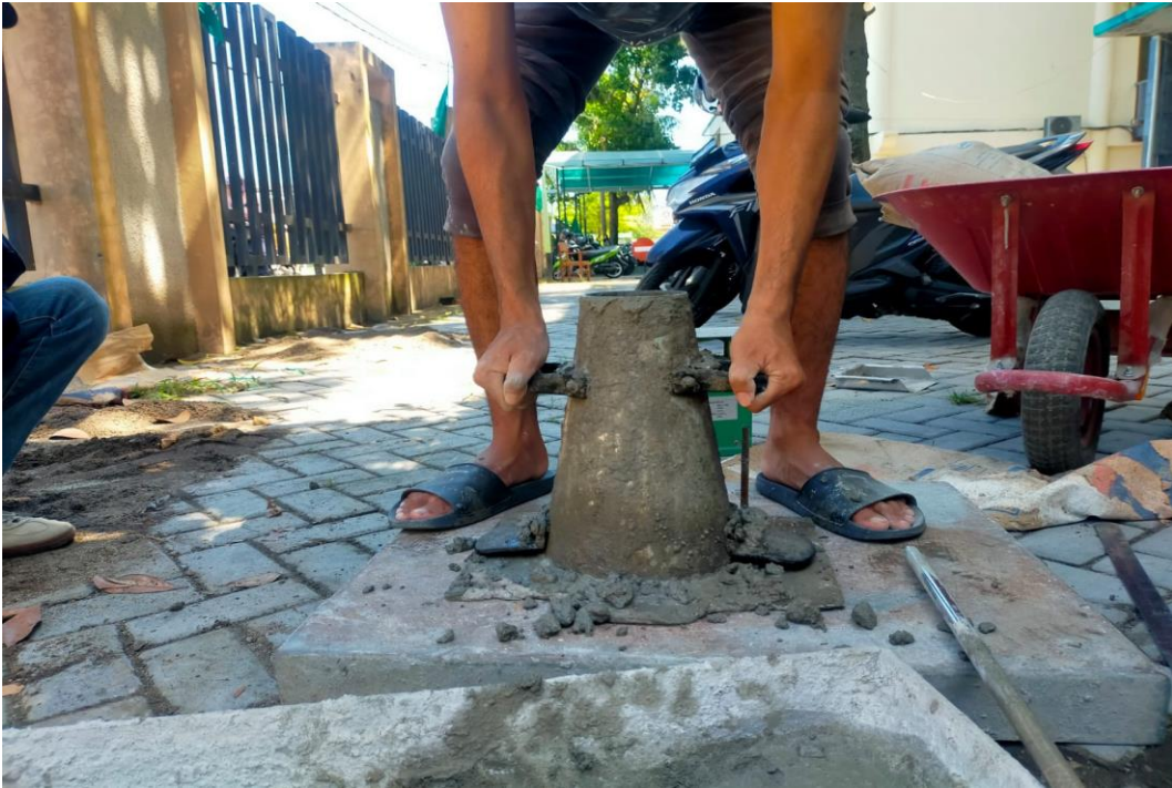
Proses Pemeriksaan Slump Test
