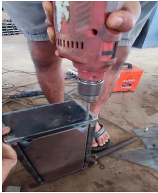
Pengeboran engsel pintu box panel
