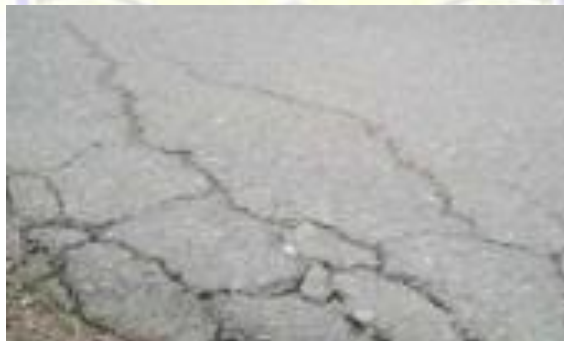
Gambar 2.8. Retak Pinggir.
