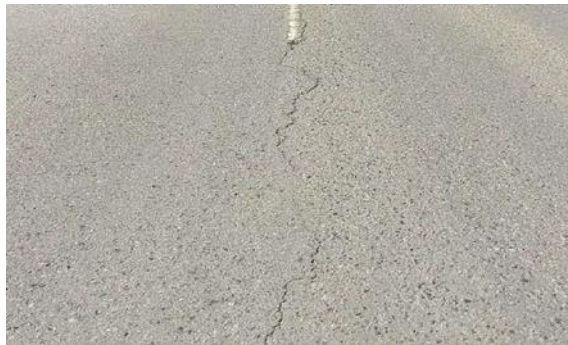
Gambar 2.6. Retak Memanjang.
