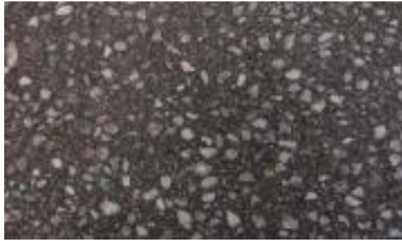
Gambar 2.32. Agregat Aus.
