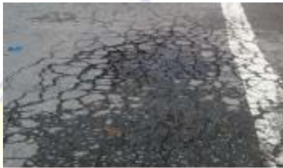
Gambar 2.2. Retak Kulit Buaya.
