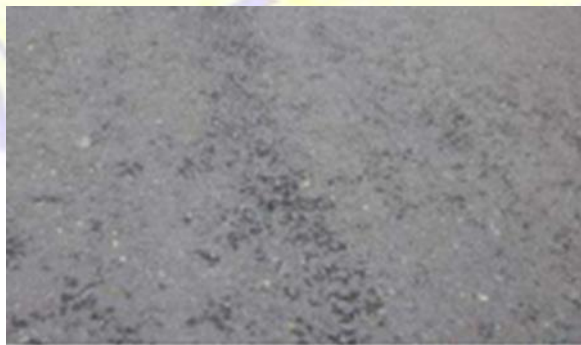
Gambar 2.28. Pelepasan Butir.
