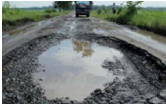
Gambar 2.26. Lubang.
