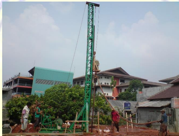
Gambar 2.9 Pekerjaan Bored Pile dengan alat Mini Crane (Sumber: CV. Jogjacamp, 2017)
