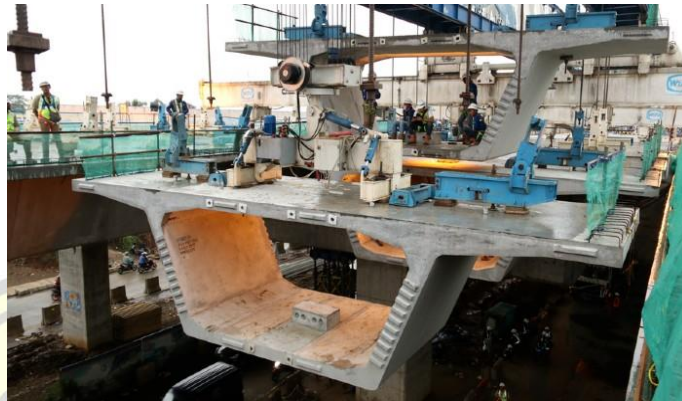
Gambar 2.5 Box girder (Sumber : https://produk.wika-beton.co.id , 2023)
