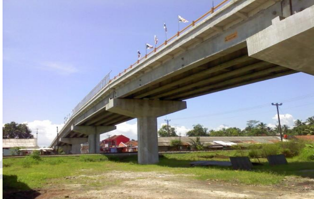
Gambar 2.2 Jembatan gelagar beton (Sumber : Sari, 2018)
