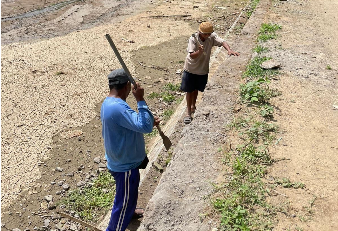
Dokumentasi Pembersihan Pekerjaan Dinding Proteksi Lereng Hulu
