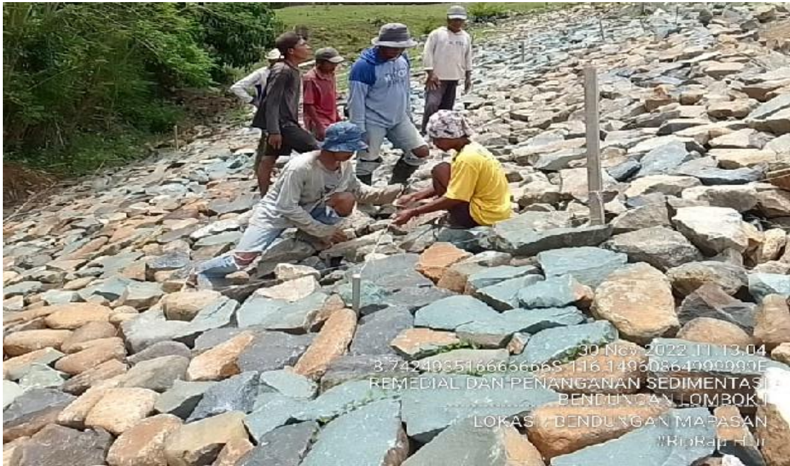
Dokumentasi Pekerjaan Rip Rap
