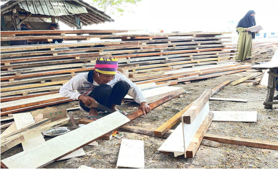
Dokumentasi Pembuatan Bekisting Pekerjaan Parapet
