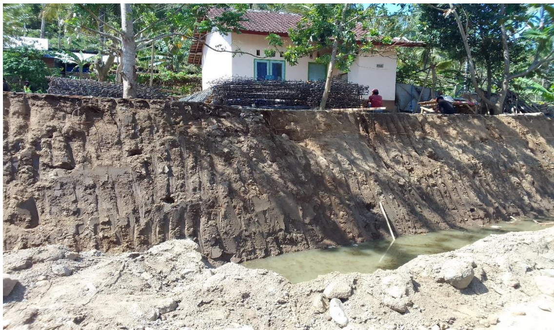
Dokumentasi Pekerjaan Dinding Proteksi Rumah Jaga
