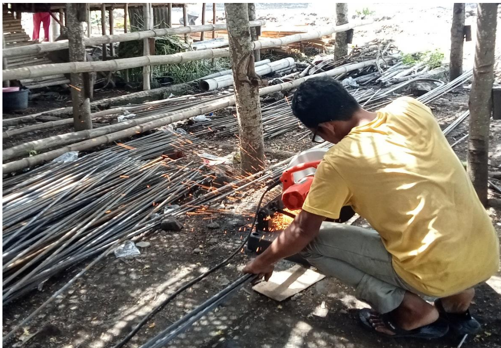
Dokumentasi Pemotongan Besi Untuk Pembuatan Parapet
