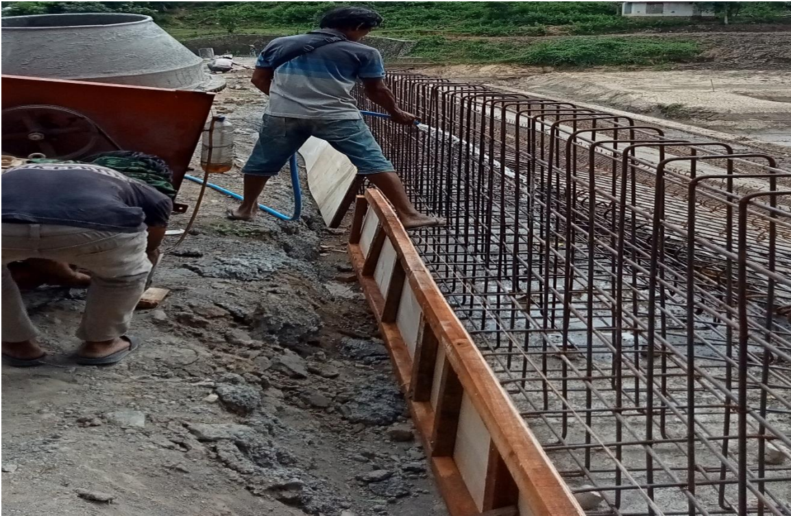
Dokumentasi Pemasangan Bekisting Pekerjaan Parapet
