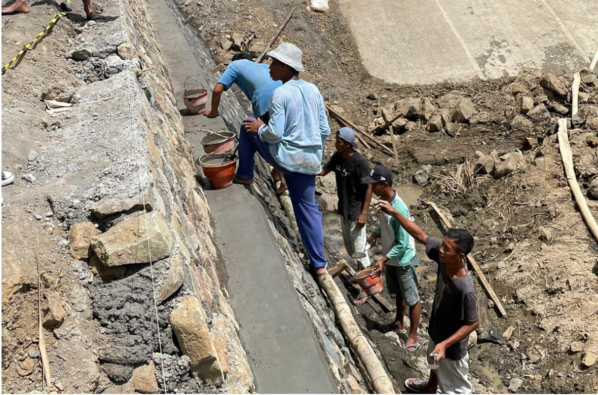
Dokumentasi Pekerjaan Acian Pada Dinding Proteksi Lereng Hulu
