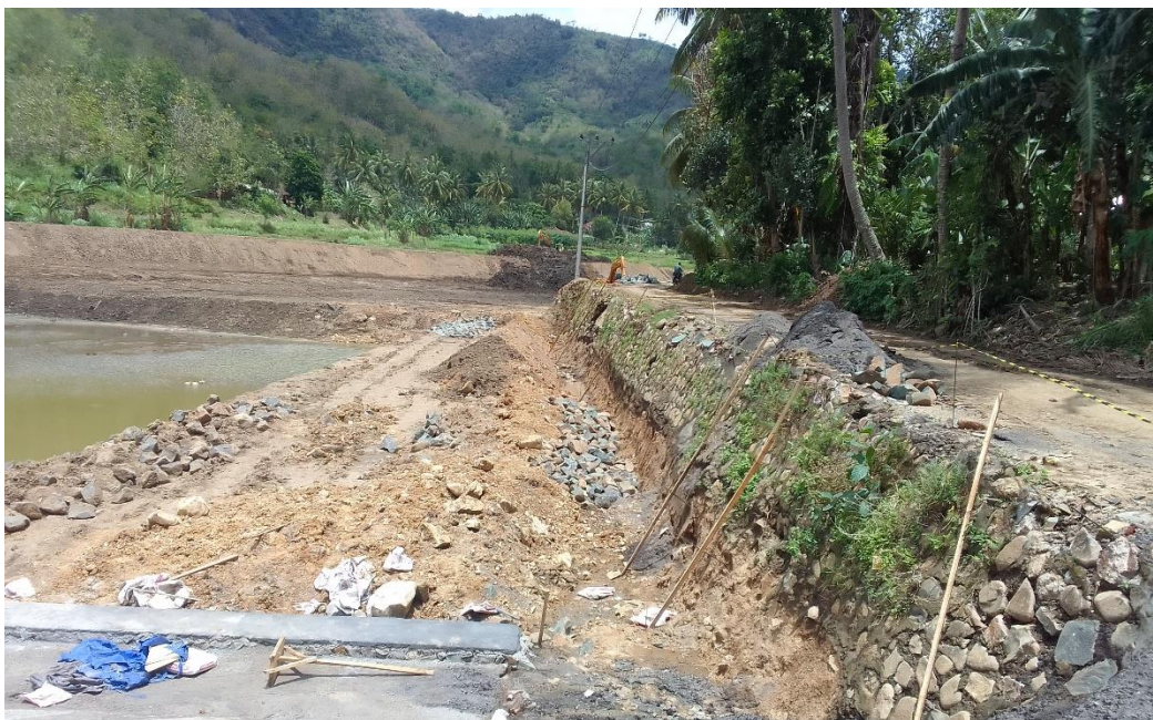
Dokumentasi Pekerjaan Galian Tanah Biasa untuk Dinding Proteksi Lereng Hulu
