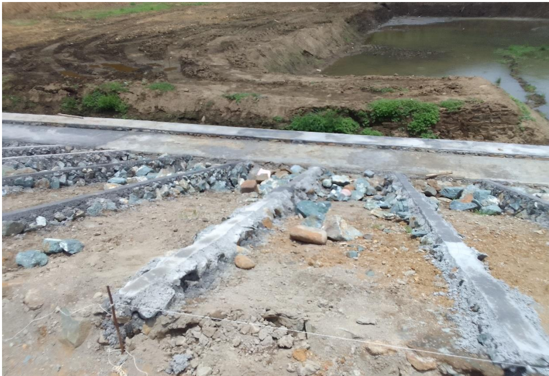
Dokumentasi Pekerjaan Perapian Lereng Hulu
