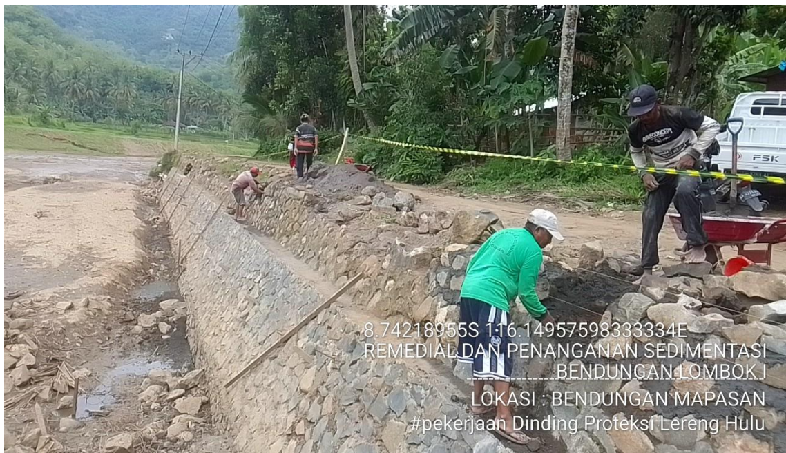
Dokumentasi Pekerjaan Dinding Proteksi Lereng Hulu
