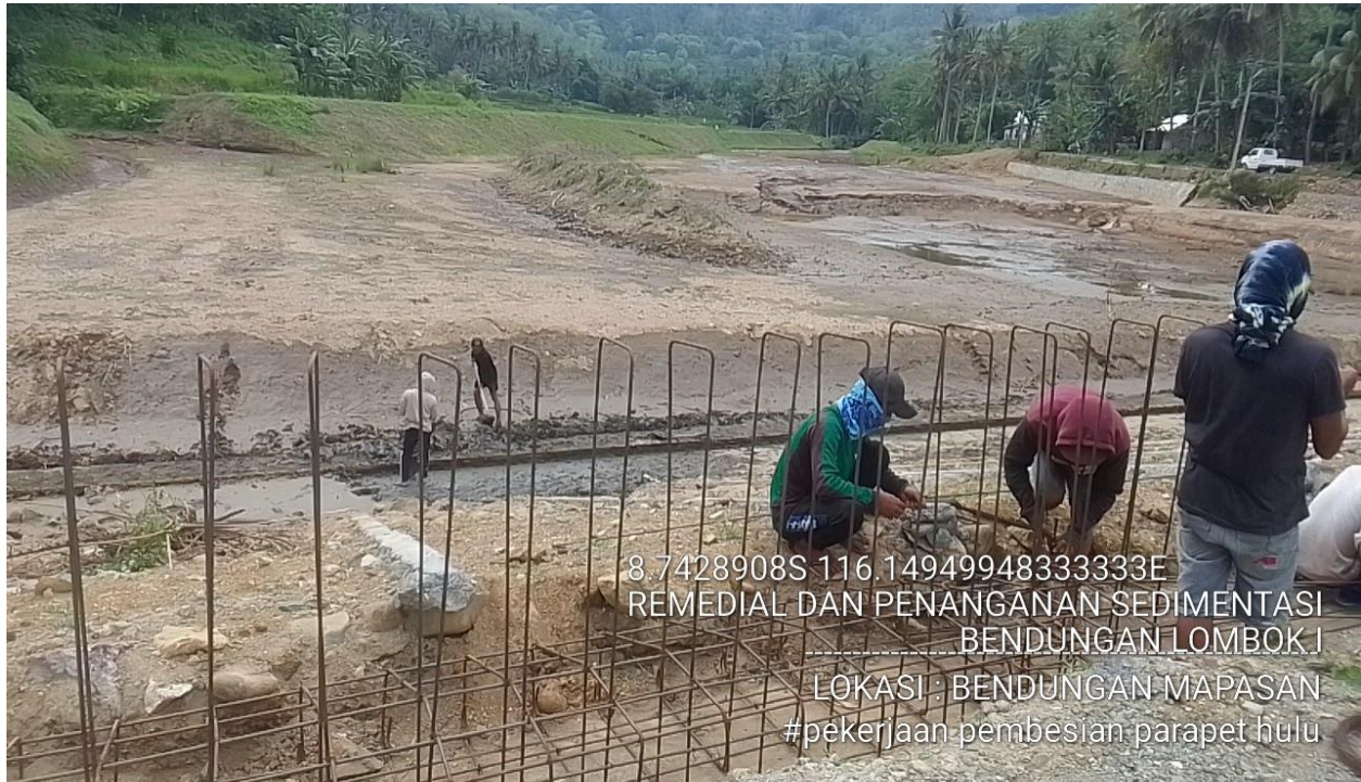
Dokumentasi Pekerjaan Pembesian Parapet Hulu
