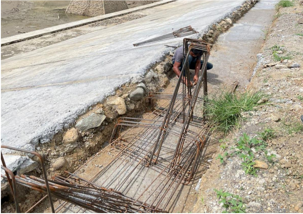
Dokumentasi Pemasangan Parapet
