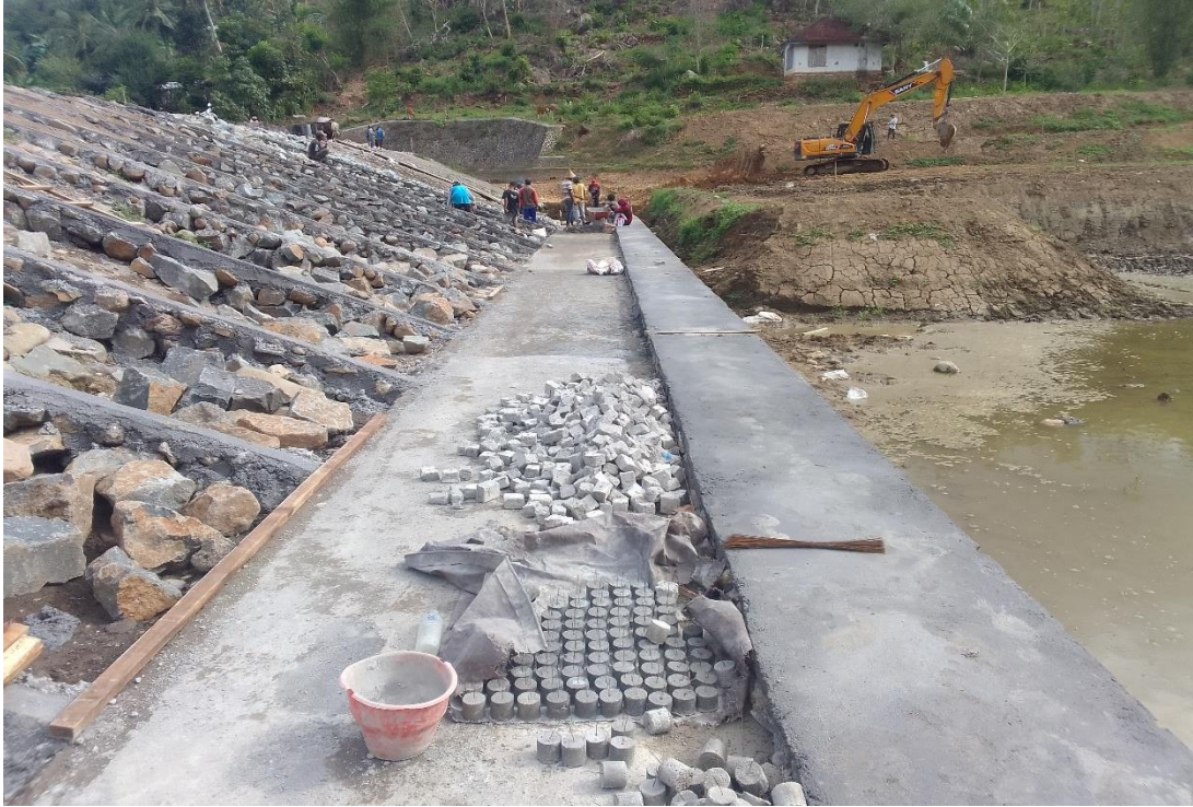
Dokumentasi Pekerjaan Hulu
