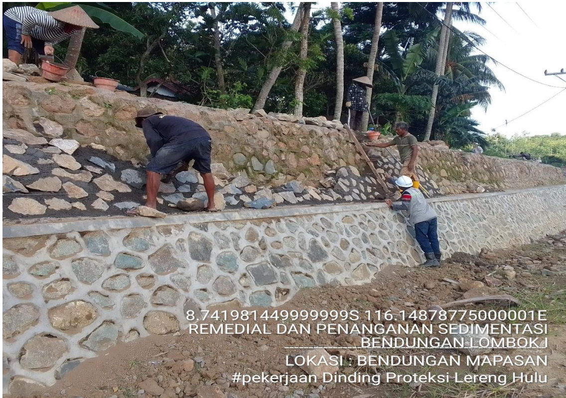
Dokumentasi Pekerjaan Dinding Proteksi Lereng Hulu
