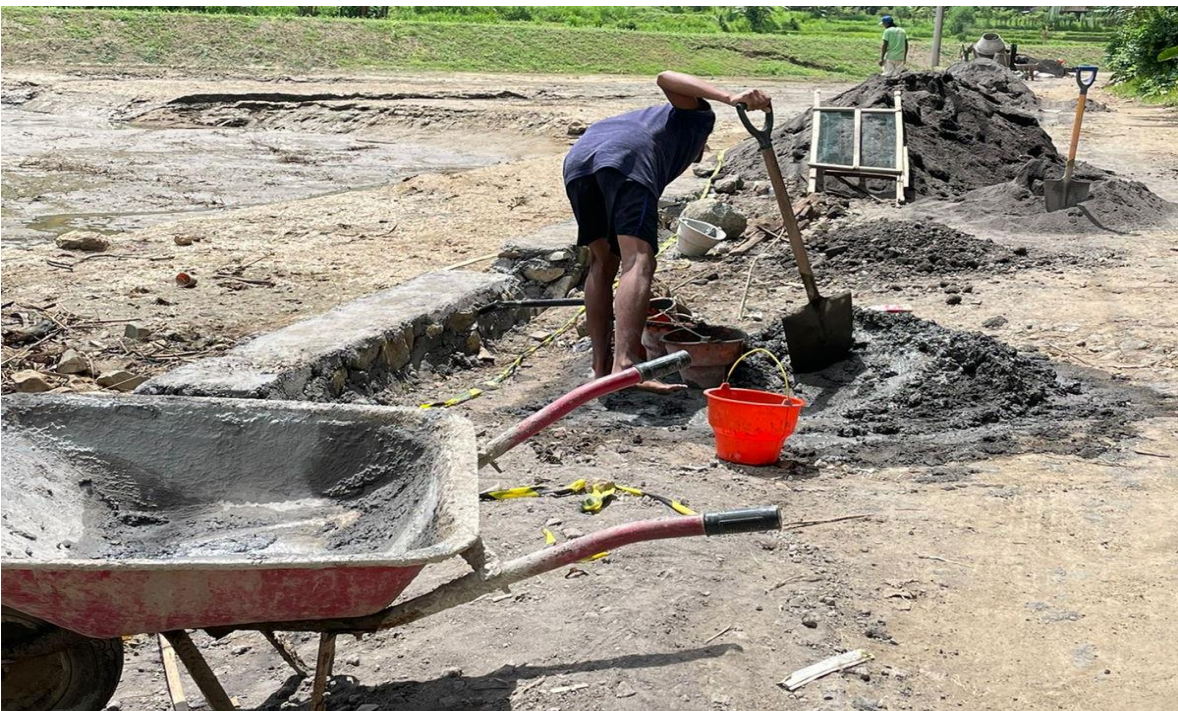
Dokumentasi Pekerjaan Acian Pada Dinding Proteksi Lereng Hulu
