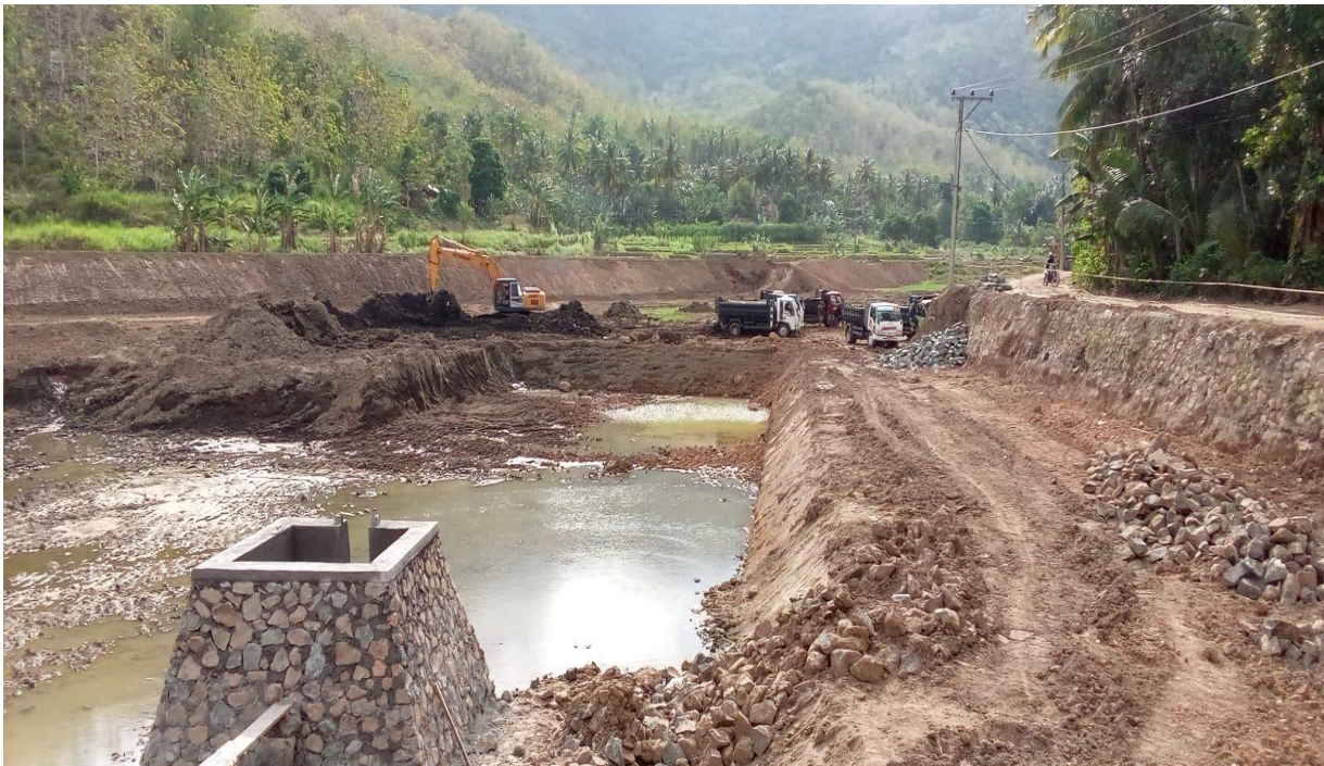
Dokumentasi Pengangkutan dan Pemindahan Hasil Pengerukan ke Area Disposal
