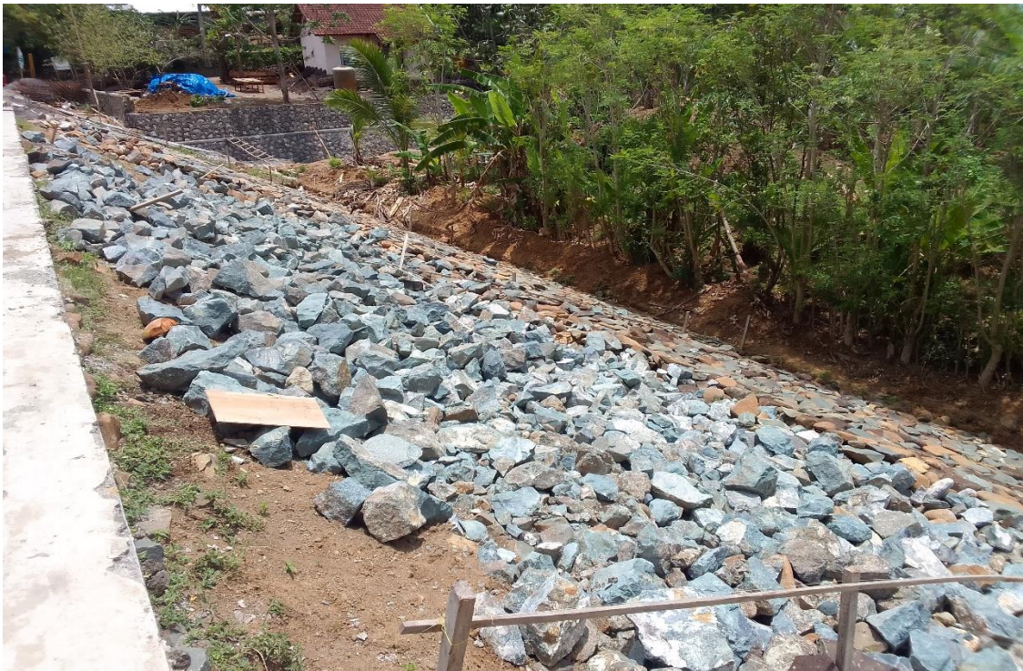
Dokumentasi Pekerjaan Perapian Rip Rap
