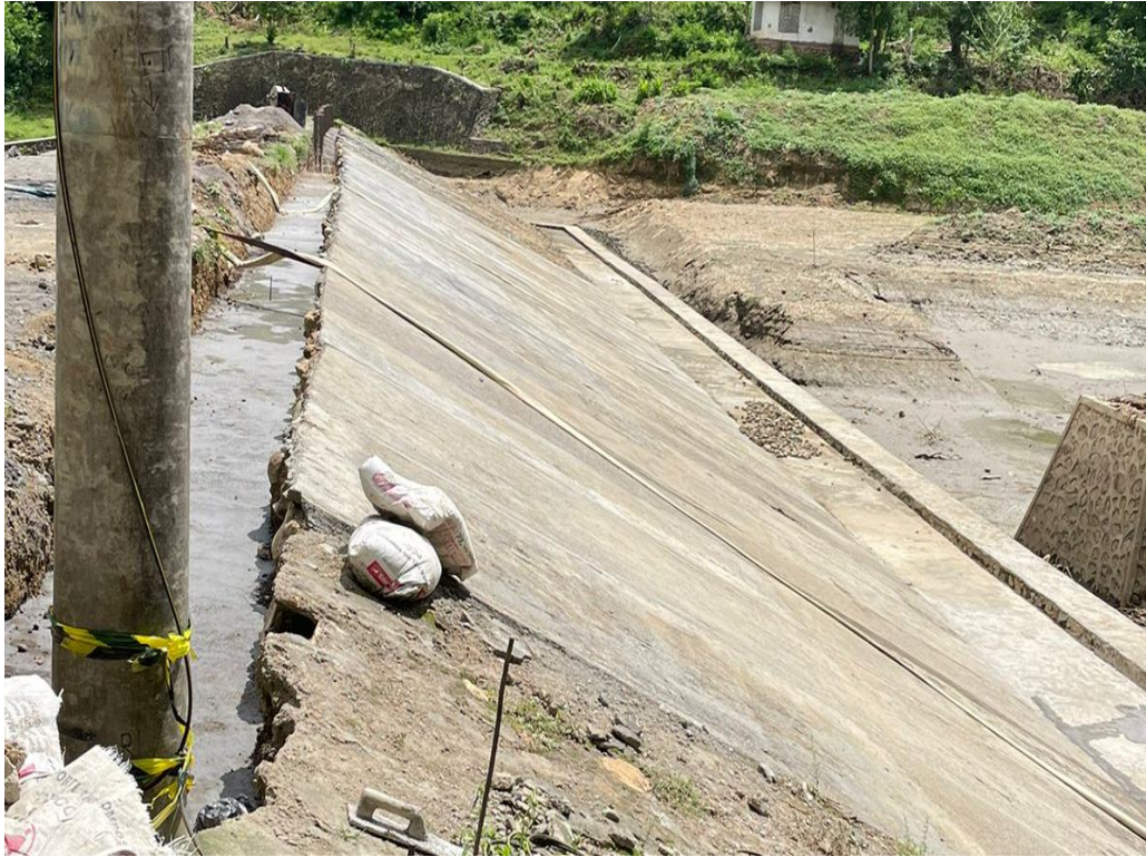
Dokumentasi Pekerjaan Perapian Lereng Hulu
