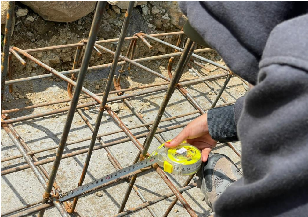
Dokumentasi Pengukuran Parapet Pada Lapangan
