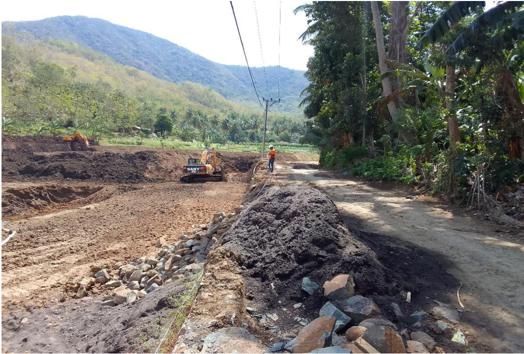
Dokumentasi Persiapan Pekerjaan Dinding Proteksi Lereng Hulu
