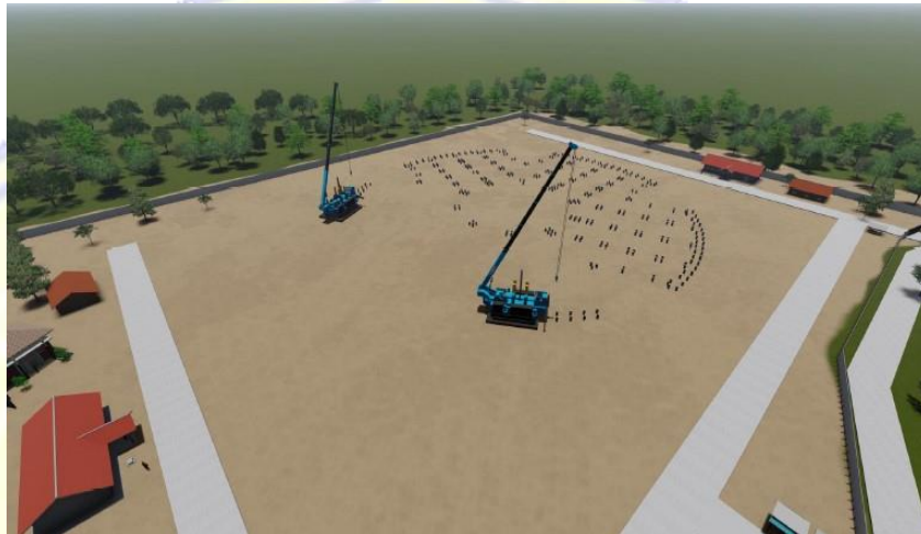
Gambar 2.15 Visualisai Pemancangan Tiang GH Display (Sumber: Metode Pelaksanaan Pekerjaan PT. ADHI KARYA, 2021)
