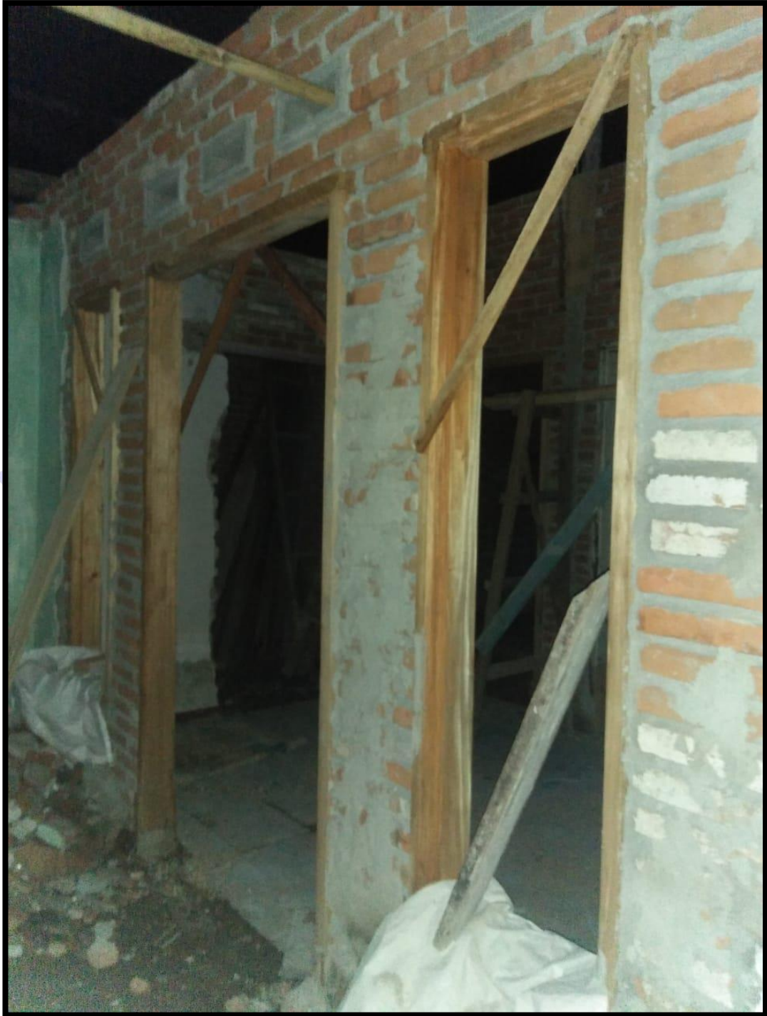
Gambar Pemasangan Kusen Pintu dan Jendela dan Pemasangan Bata
