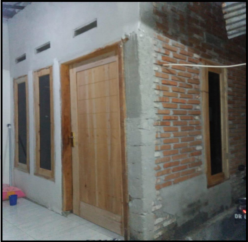
Gambar pengerjaan Acian
