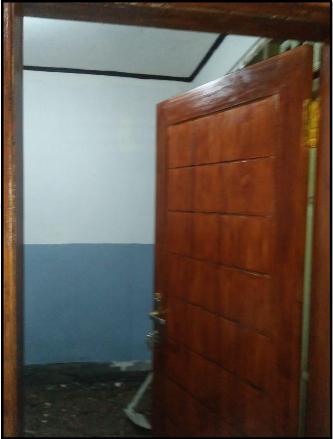
Gambar Setelah Pemasangan Kusen Pintu dan Daun Pintu
