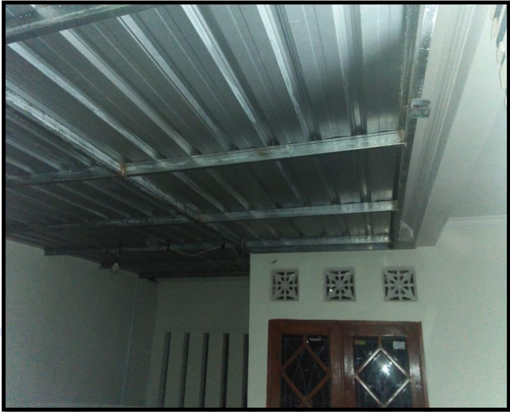
Gambar Pemasangan Penutup Atap Spandek Plesteran
