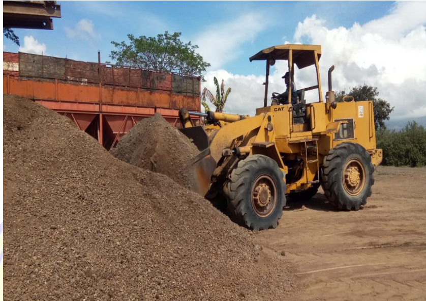
Poto Pekerjaan Tanah di PT.Kresna Karya dengan menggunakan Alat Berat Wheel Loader
