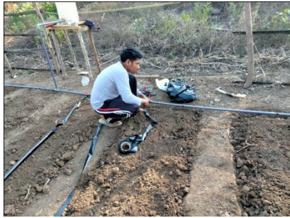
Pemasangan selang irigasi
