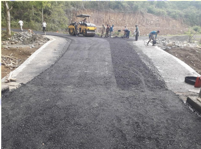
Gambar 7.1. Pemadatan Aspal
