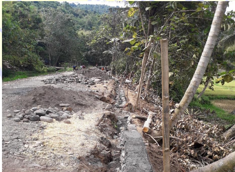
Gambar 1.2. Pembuatan Tembok Penahan Jalan
