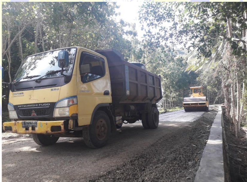
Gambar 4.1. Penyiraman dan Pemadatan LPA
