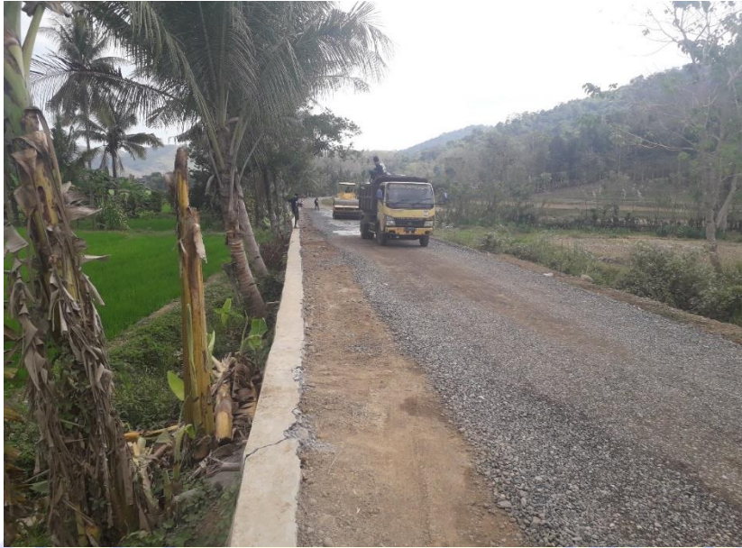
Gambar 4.2. Penyiraman dan Pemasangan LPA
