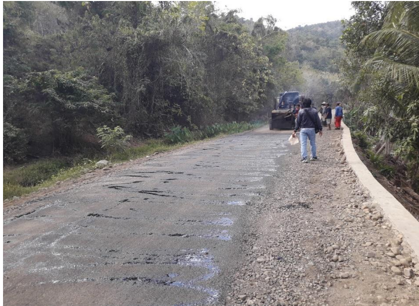
Gambar 5.2. Lapis Resap Pengikat ( Prime Coat )
