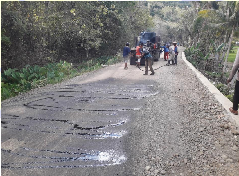
Gambar 5.1. Lapis Resap Pengikat ( Prime Coat )
