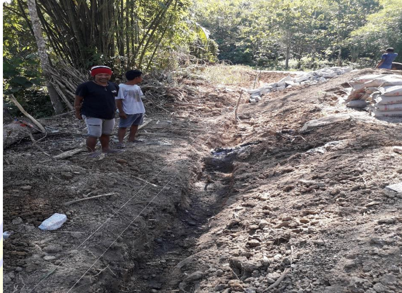
Gambar 1.1. Pembuatan Tembok Penahan Jalan
