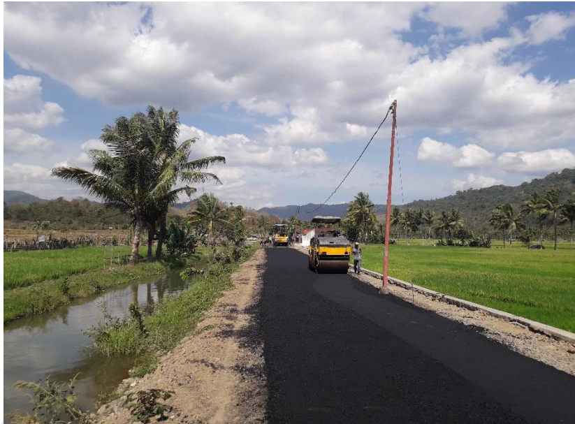
Gambar 7.2. Pemasangan Aspal
