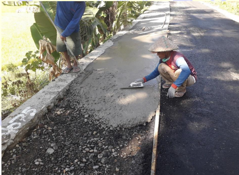
Gambar 8. Pembuatan bahu Jalan
