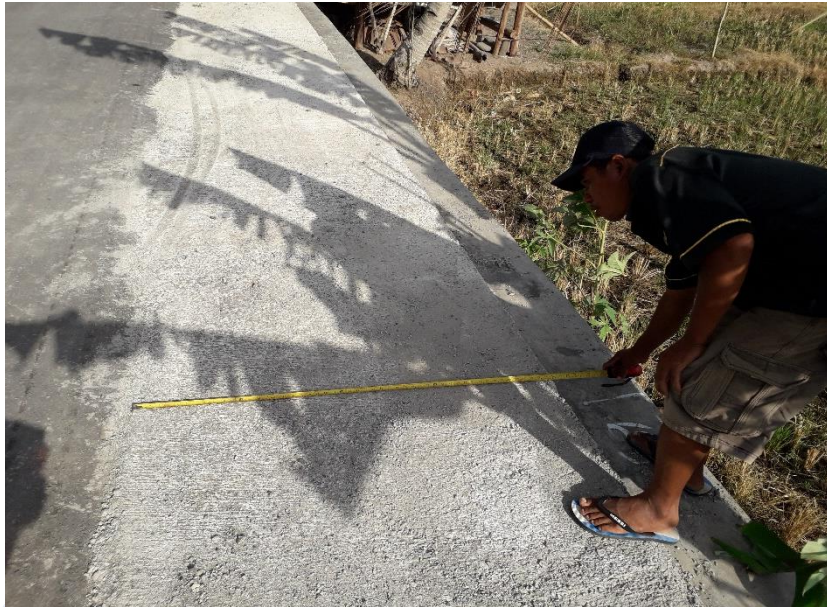
Gambar 9.1. Pengukuran bahu Jalan
