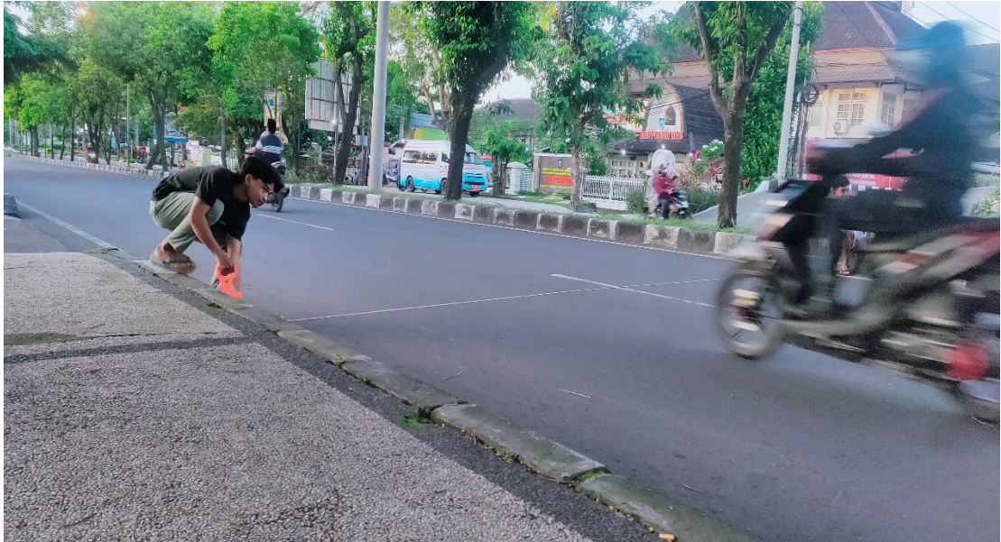
Gambar L.1 Mengukur lebar jalan
