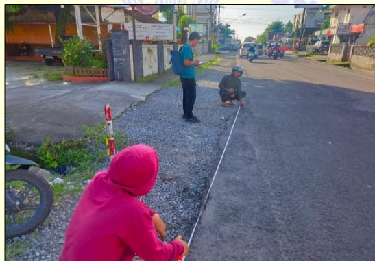
Gambar Pengukuran Panjang Jalan Sta 1+725 – 1+750
