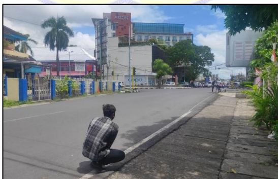
Gambar Pengukuran Panjang Jalan Sta 0+000 – 0+025
