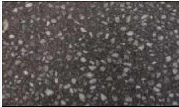
Gambar 2.32. Agregat Aus.
