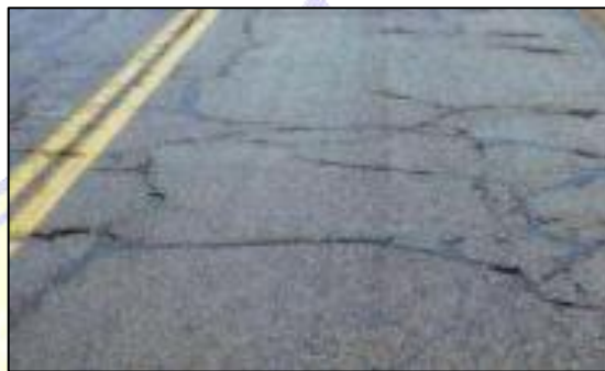
Gambar 2.12. Retak Kotak ( Block Cracking ).
