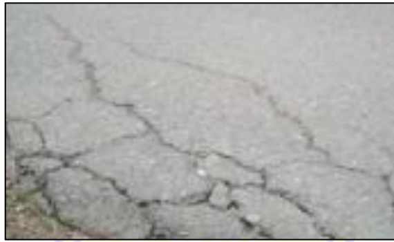
Gambar 2.8. Retak Pinggir.
