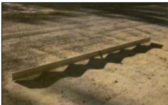
Gambar 2.16. Retak Keriting ( Corrugation ).
