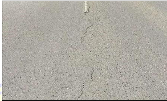
Gambar 2.6. Retak Memanjang.
