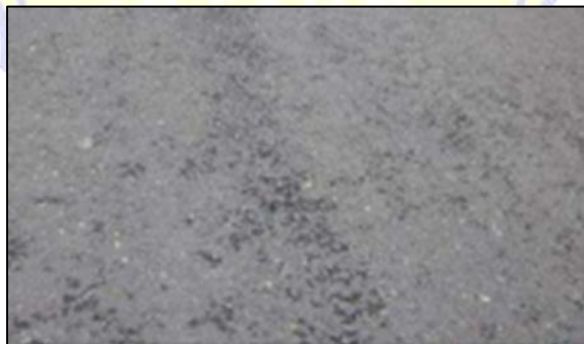
Gambar 2.28. Pelepasan Butir.
