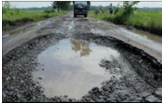
Gambar 2.26. Lubang.
