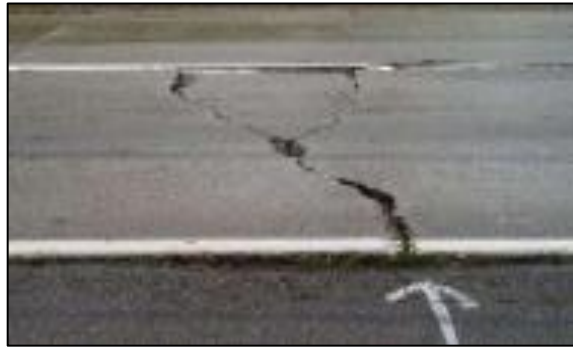
Gambar 2.10. Retak Sambungan Bahu Perkerasan.
