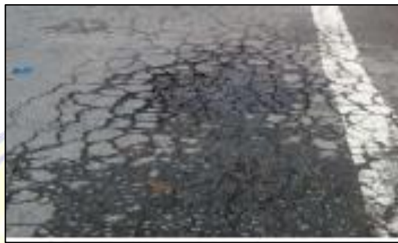
Gambar 2.2. Retak Kulit Buaya.
