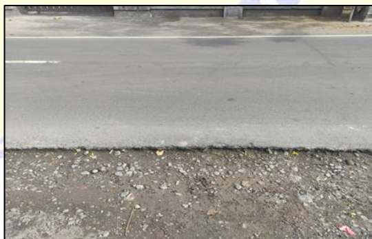
Gambar 2.30. Penurunan Pada Bahu Jalan.
