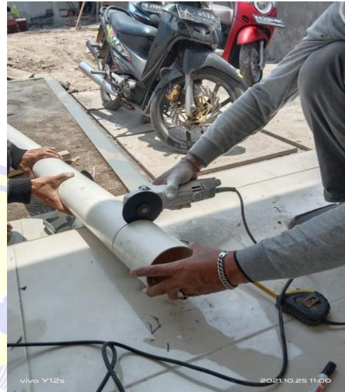
Gambar 2 proses pemotongan pipa
