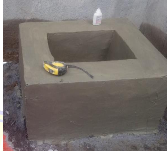
Bak Inlet Untuk Mengisi Bahan
