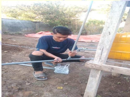
Pemasangan jaringan irigasi
