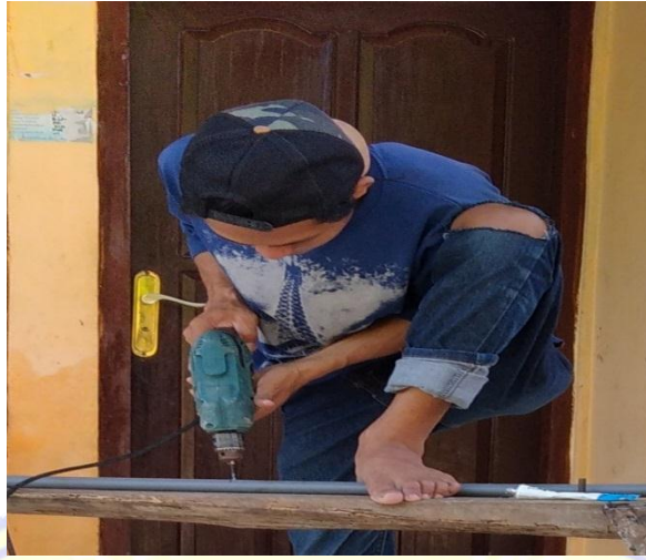
Pembuatan lubang emiter
