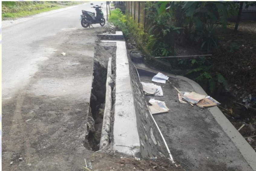
Gambar 3.3 Pemasangan DPT
