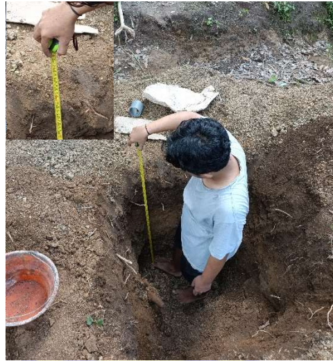
Gambar 3.22 Lubang Uji (Test-Pit)
