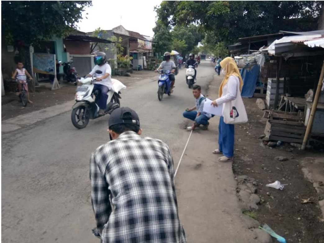
Gambar pengambilam data kerusakan
