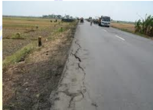
Gambar 2. 13 Edge Craking (Retak tepi)
