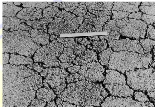
Gambar 2.1 Alligator Cracking (Retak Kulit Buaya)
