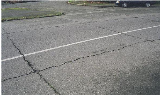
Gambar 2. 19 Longitudinal & Transfersal Cracking (Retak Memanjang Dan Melintang)
