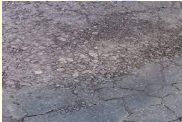
Gambar 2. 37 Weathering/Ravelling (Pelepasan Butir)
