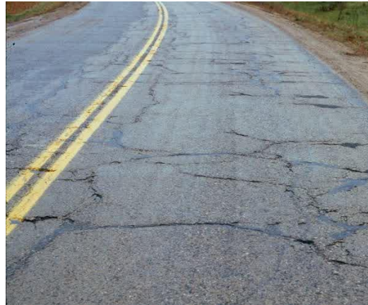
Gambar 2. 5 Block Cracking (Retak Kotak)
