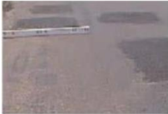
Gambar 2. 21 Patching And Utility Cut Patching (Tambalan dan Tambalan Pada Galian Utilitas)
