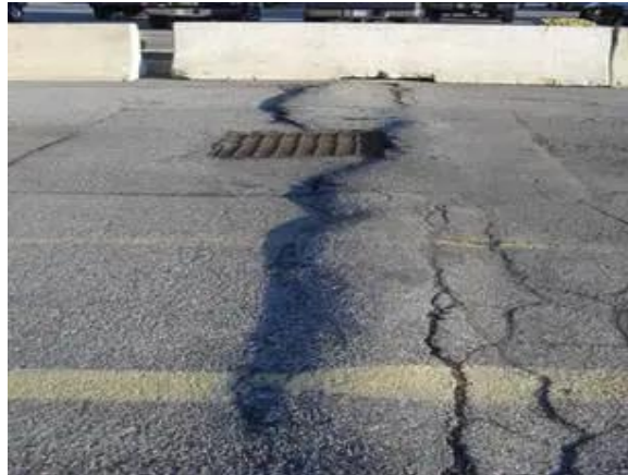
Gambar 2. 7 Bumb and Sags (Cembung dan Cekung)
