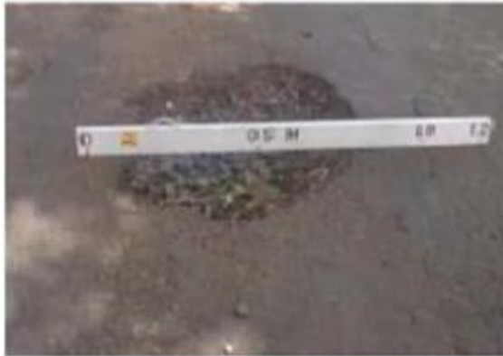
Gambar 2. 25 Photoles (Lubang)
