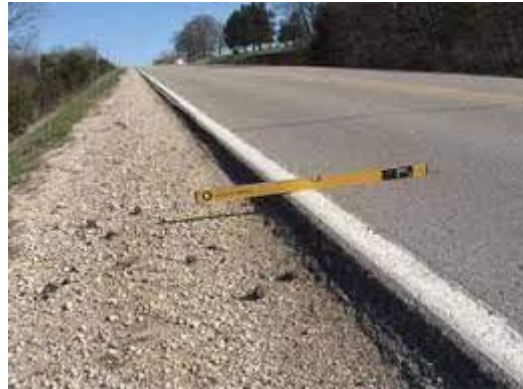
Gambar 2. 17 Lane/Shoulder Drop Off (Penurunan Pada BahuJalan)
