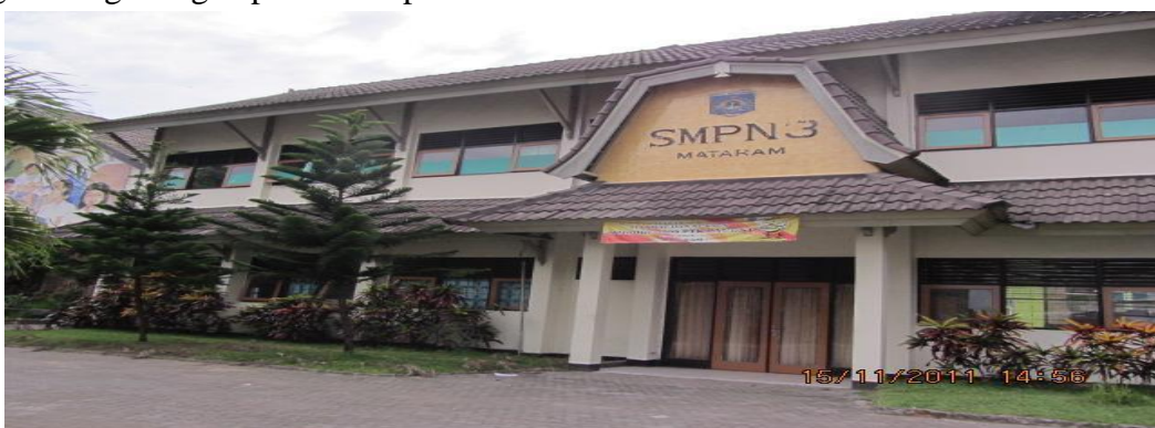
Gambar 3.2 Gedung SMPN 3 Mataram
