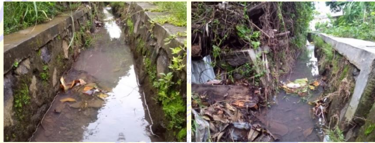
Gambar 1. Sampah pada saluran irigasi (Sumber : Dokumentasi Pribadi)
