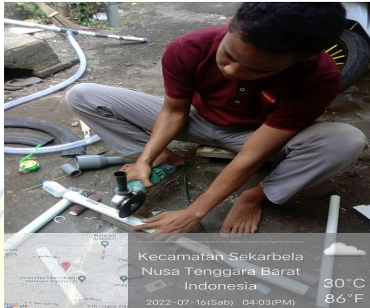
**Gambar 1. Proses Pemotongan Pipa**
