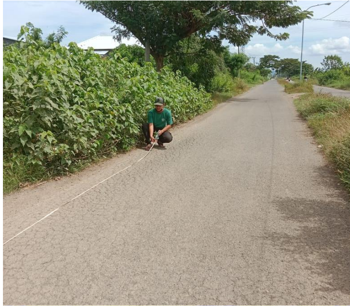
Pengukuran STA jalan
