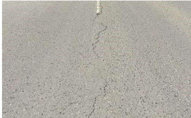
Gambar 2.4 Retak Memanjang
