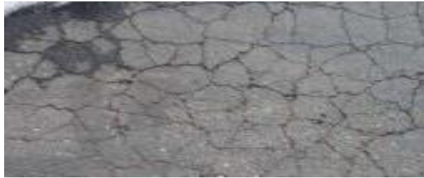
Gambar 2.10 Retak Susut
