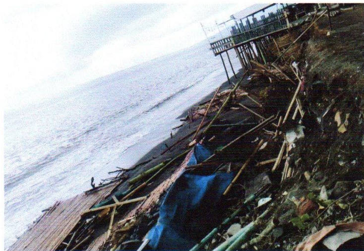
Foto kerusakan lapak akibat dampak dari abrasi (diakhir tahun dan diawal tahun di kawasan pantai Mapak Indah)
