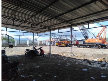
Area Parkiran Kendaraan Dan Lapangan Penumpukkan 58 x 34 m
