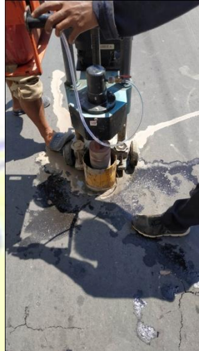
Gambar 4.2 Mengambil benda uji menggunakan core drill
