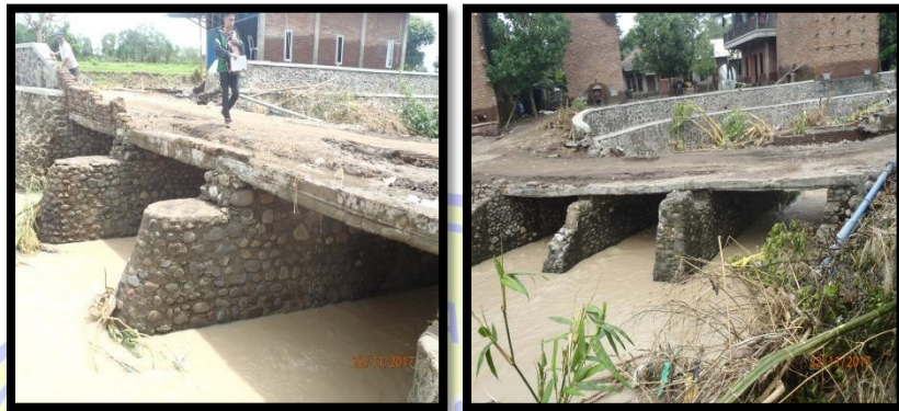
Gambar 3.2 (a). kondisi jembatan dihilu (b). kondisi jembatan dihilir
