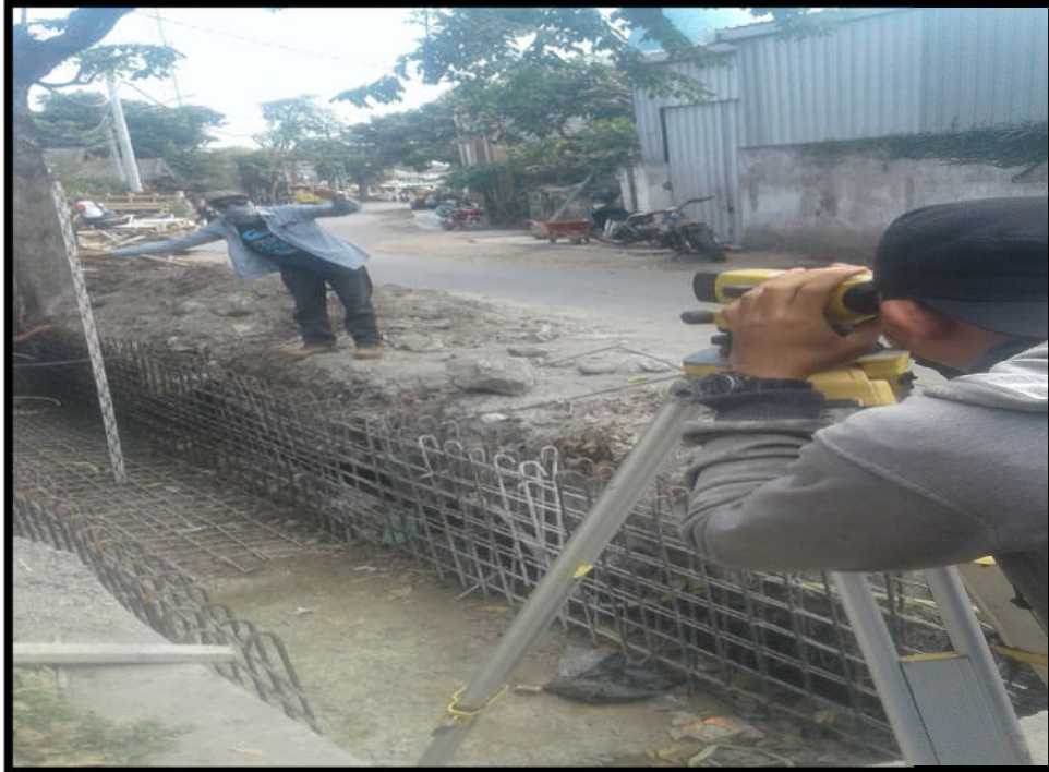
Pengukuran beda tinggi / kemiringan saluran
