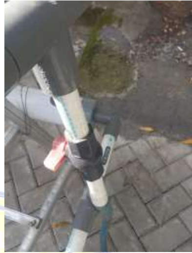
Pemasangan Stop Kran
