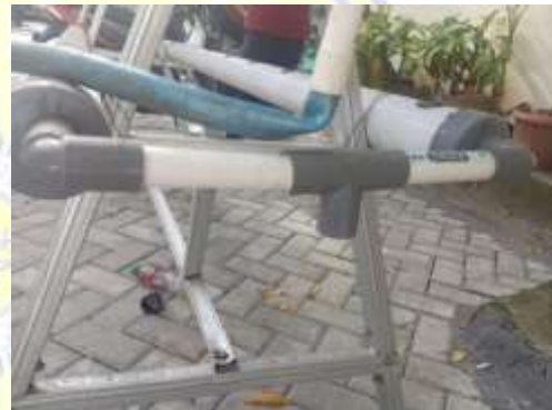
Pemasangan Penyambung Pipa Aliran Air Nutrisi
