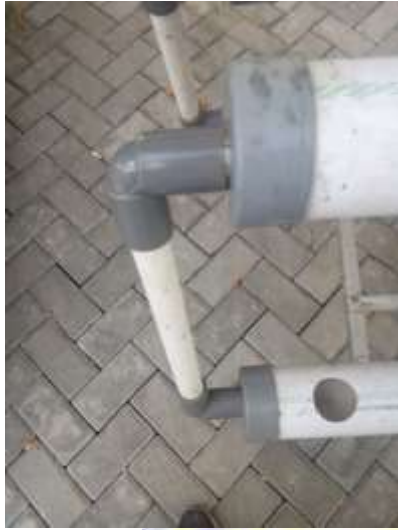
Pemasangan DOP Penutup
