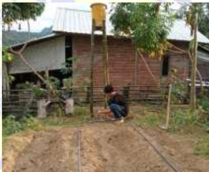
D. Pemasangan Instalasi
