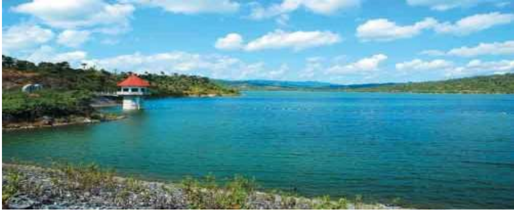
Bendungan pengga utama
