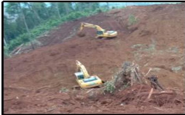
Gambar 2. 3 Pengupasan tanah pucuk
