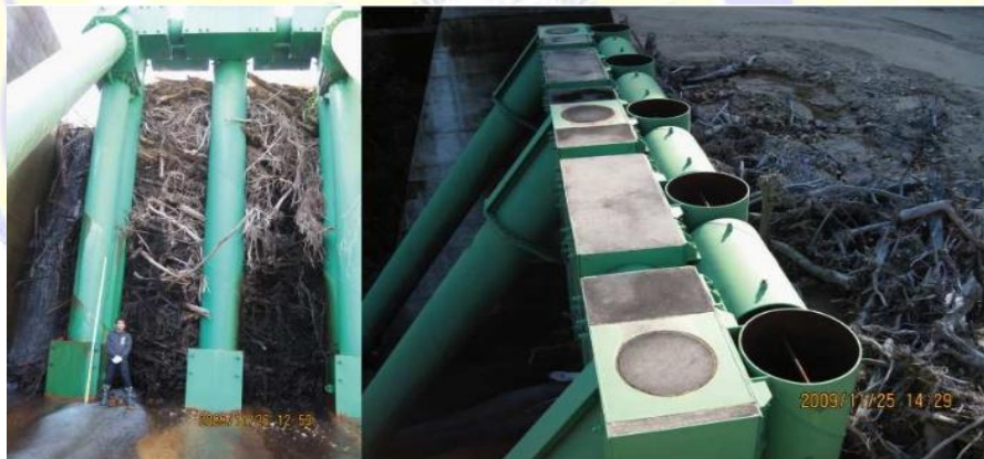
( c ) Debris yang tertahan oleh sabo dam type terbuka [9]
