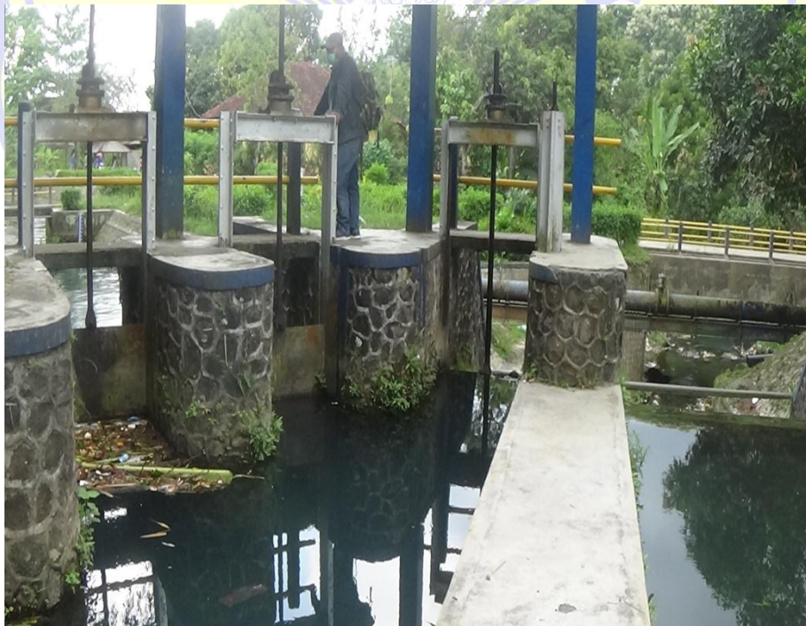
Gambar Bangunan pembagi air
