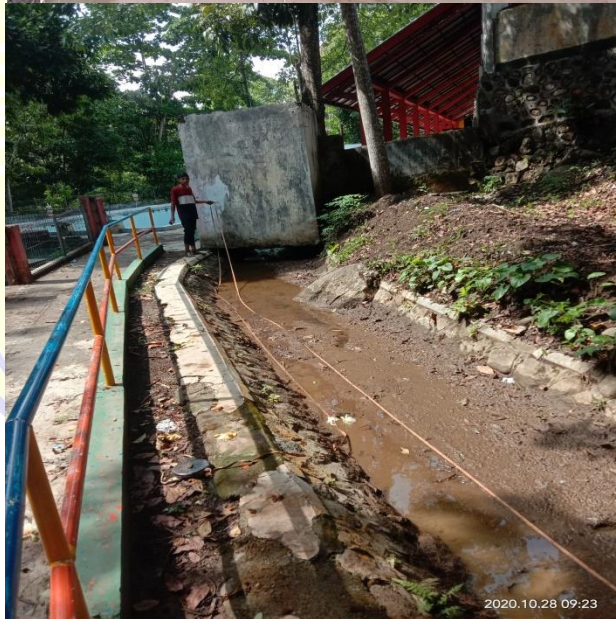
Keterangan: mengukur panjang saluran
