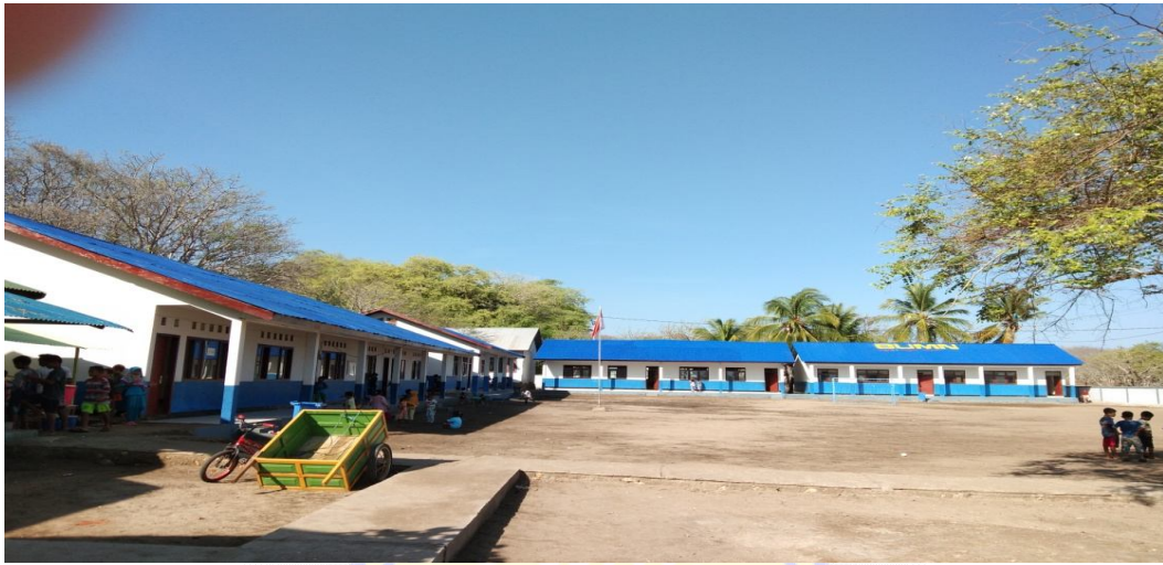
Kondisi bangunan SD pulau Rinca setelah perbaikan
