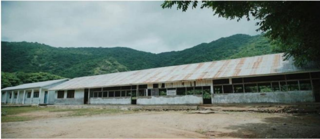
Proses perbaikan bangunan SD kerora
