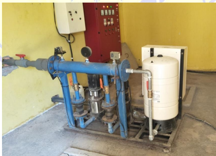
Gambar 2.1 Pompa air untuk bangunan
