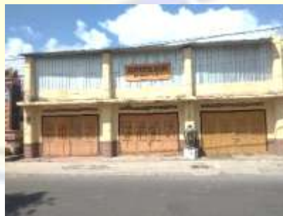
Gambar 4.1 Kondisi Fasad Wilayah Amatan Selatan Penggal 1
