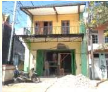
Gambar 4.3 Kondisi Fasad Wilayah Amatan Selatan Penggal 3
