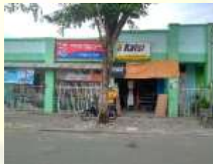
Gambar 4.6 Kondisi Fasad Wilayah Amatan Utara Penggal 2
