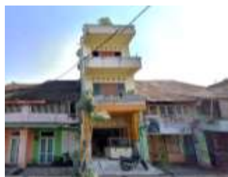
Gambar 4.4 Kondisi Fasad Wilayah Amatan Utara Penggal 1
