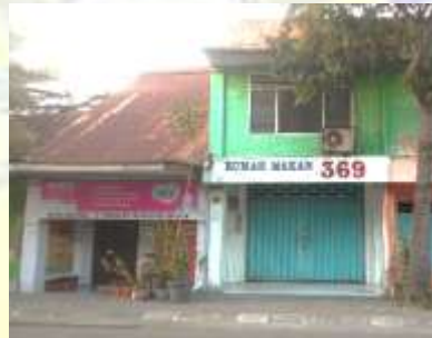
Gambar 4.5 Kondisi Fasad Wilayah Amatan Utara Penggal 2
